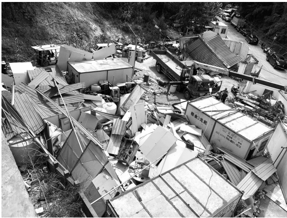
拆除违建彩钢板房屋
