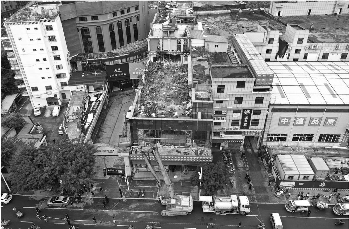
违建的龙发大厦附属楼被拆除
