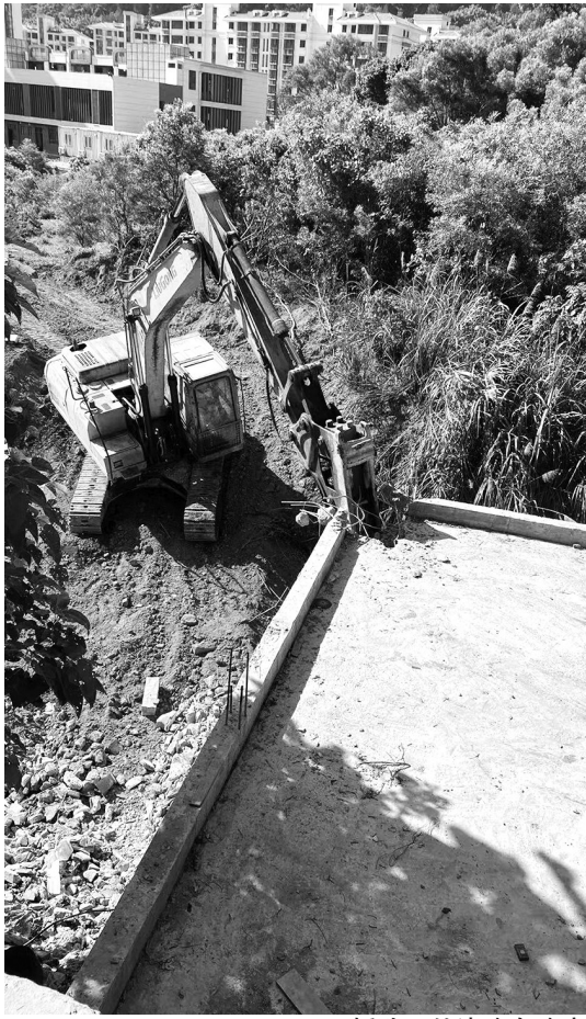
拆除一处违建自建房
