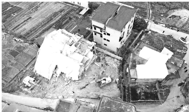
整栋违建房屋被拆除
