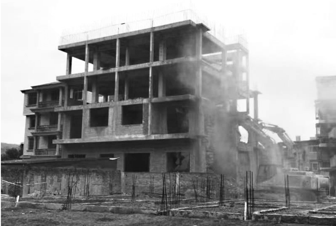
一处违建自建房屋被拆除
