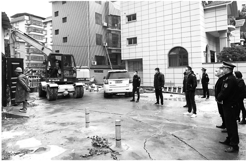
执法人员发现吴航一处违建立即拆除
