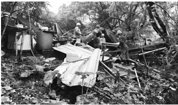
拆除违建现场
