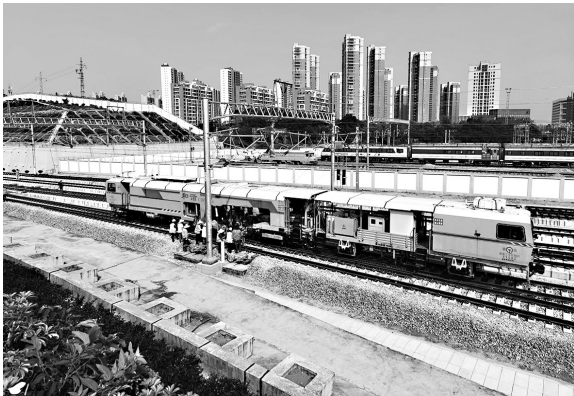
8台世界先进的大型养路机械,分别在莆田站、厦门北站、漳州站对轨道进行全方位精调作业
