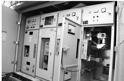
变压器内部零件被盗
