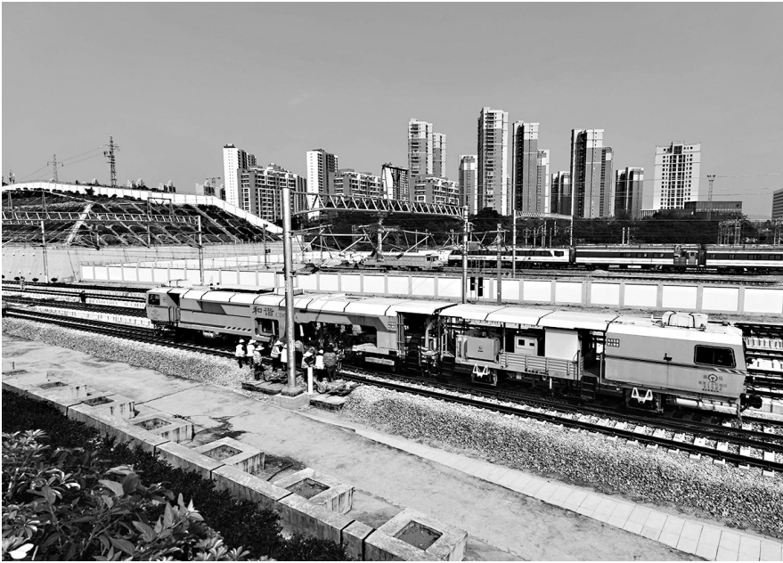
鹰潭工务机械段抽调了8台世界先进的大型养路机械,分别在莆田站、厦门北站、漳州站对轨道进行全方位精调作业
