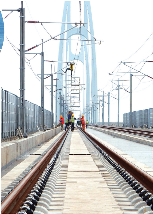
安海湾特大桥为我国高铁建设中,首次在跨海斜拉桥上实现无砟轨道铺设
