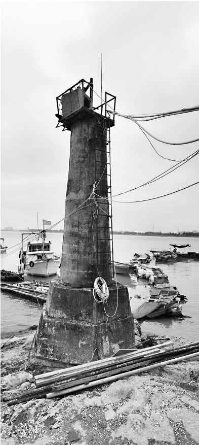
外墙斑驳的灯塔
