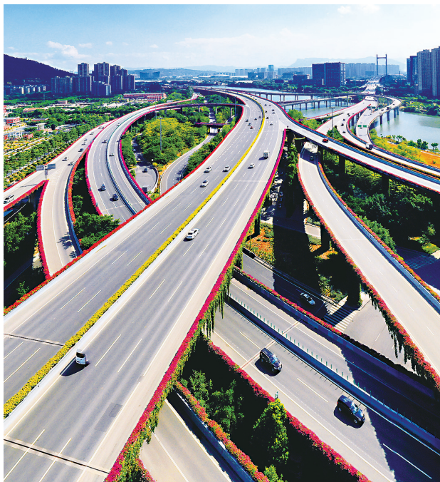
三角梅扮靓福州空中廊道(福州市绿化管理处供图)
