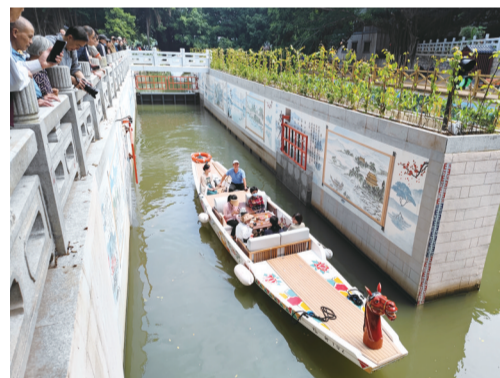
水位,方便游船通航 白马河船闸调整上下游
