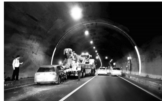
天龙山隧道内正在拖离最后一辆事故车
