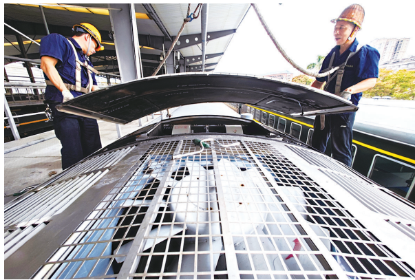
检车员拆除空调机组上的盖板
