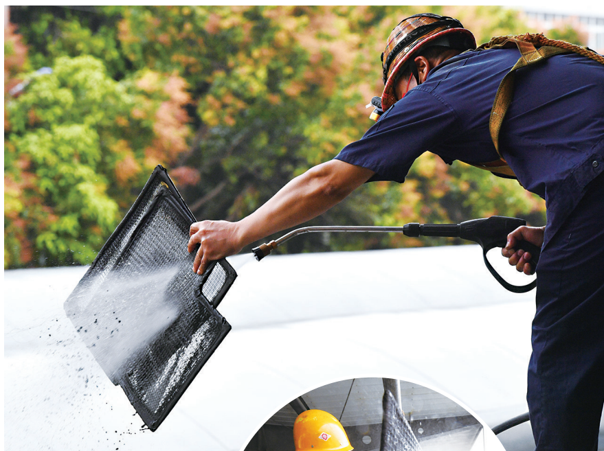
反复冲洗,直至一尘不染 回风网用高压水枪
