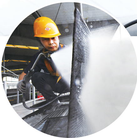
反复冲洗,直至一尘不染 回风网用高压水枪
