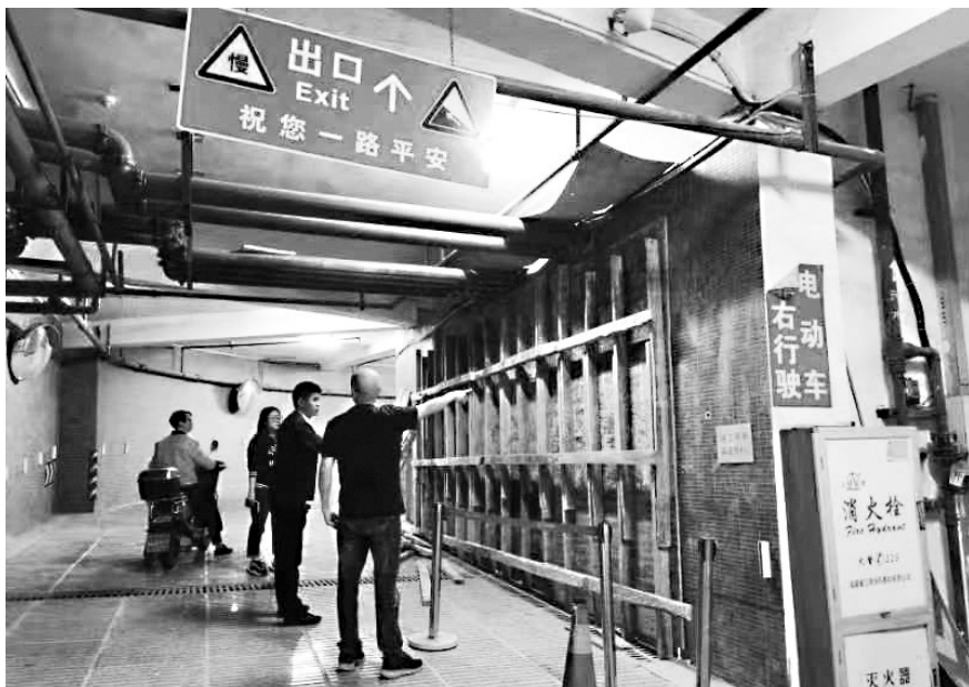
地下室被砸开大口的钢筋混凝土填充墙,已用木板封住
