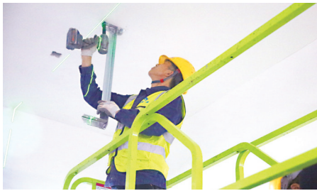
「五一」期间,福州市中医院五四北院区内科施工人员正争分夺秒地推进工程建设
