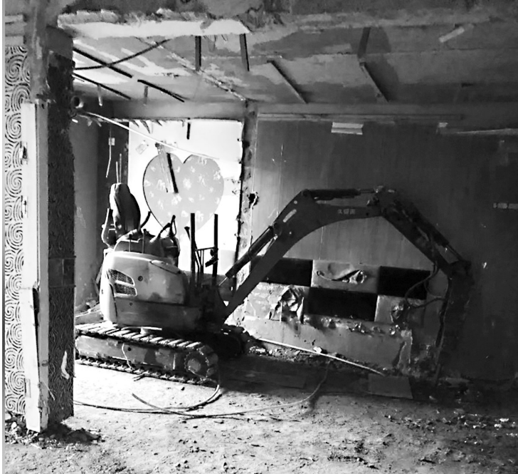
网络图片显示,租户装修时使用了钩机等大型设备
