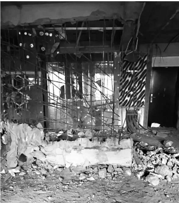
网络视频显示,正在装修的三楼室内,多面墙体被拆除,其中一面墙体钢筋缠绕
