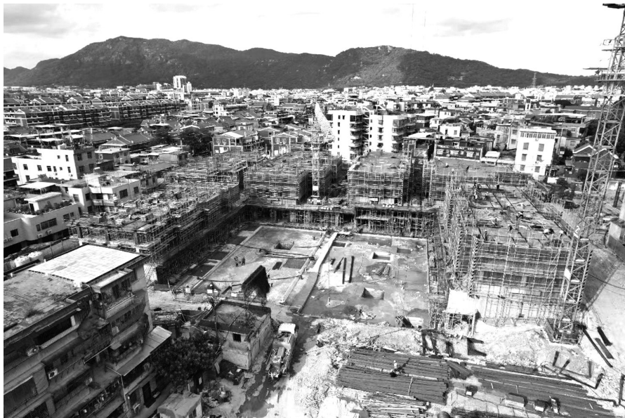
该项目位于泉州古城片区,“五一”假期刚过,施工就进入火热状态
