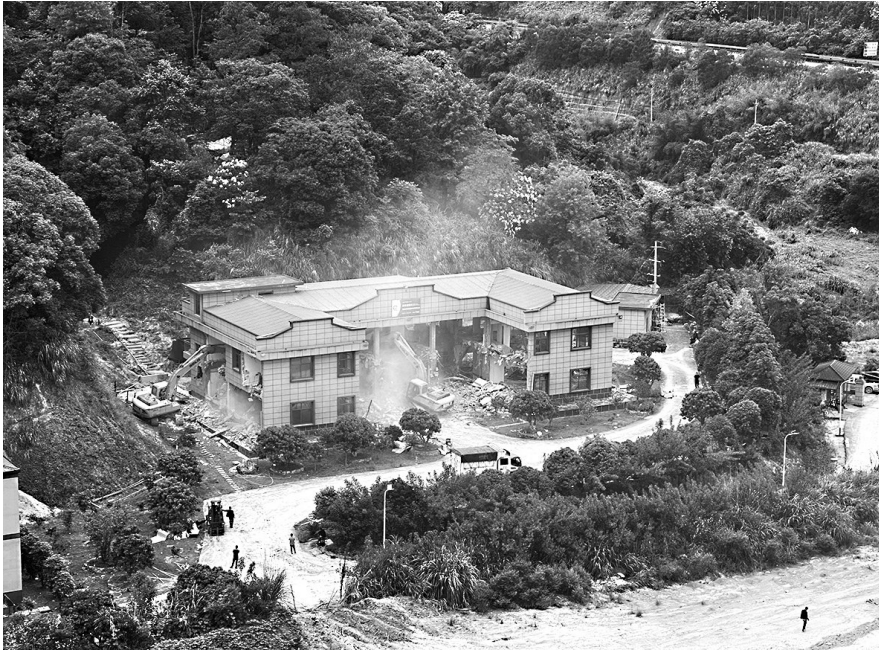
两台拆楼机正在拆楼
