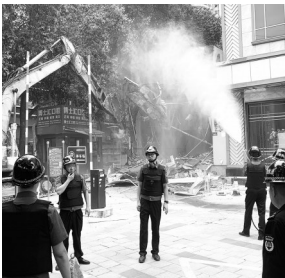
执法人员对长乐北路的违建进行拆除
