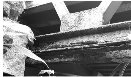
记者在桥下看到,桥主梁的表皮已经脱落
