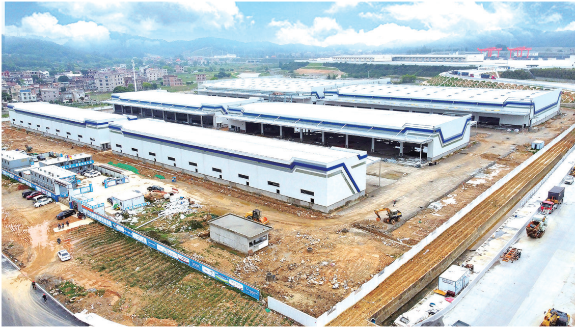
该项目一期1标段工程进入收尾阶段
