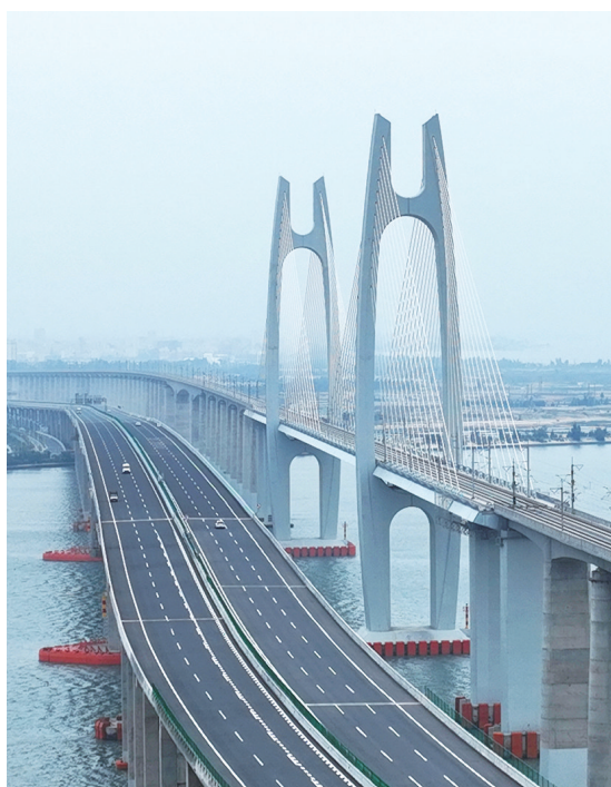
4月12日拍摄的新建福厦铁路安海湾跨海大桥(右)(新华社/图)
