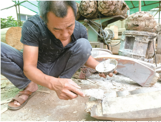
木工师傅对虫蛀木构件进行清理修补
