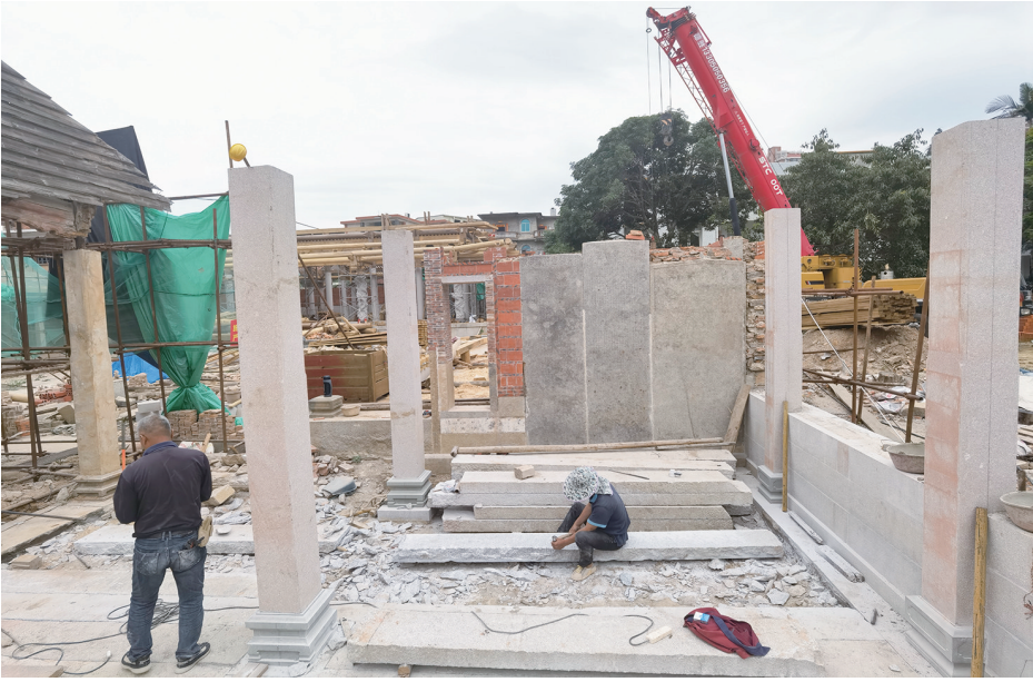
海都记者走进南安文庙遗址，看到施工师傅正在有条不紊地忙碌着
