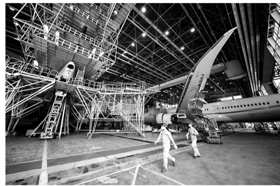
厦门太古飞机工程有限公司的维修机库一角
