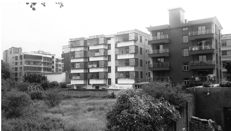
违章建筑仍未拆除
