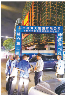
严查建筑工地噪音
