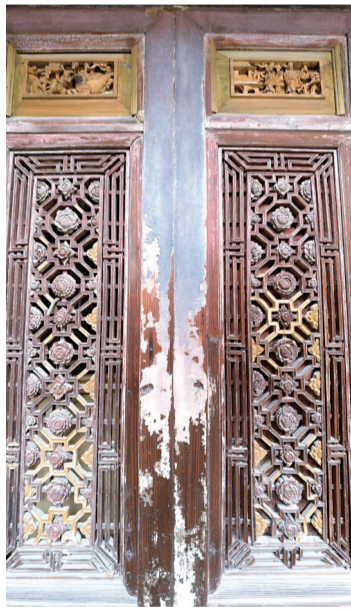
遵循修旧如旧原则修复的木窗
