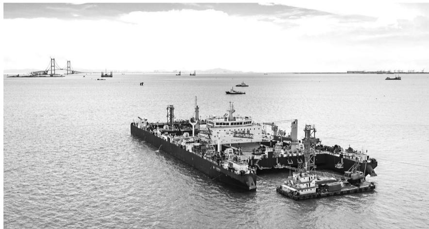
“一航津安1”号在沉放安装E23管节和最终接头,背后是建设中的深中通道伶仃洋大桥 (新华/图)
