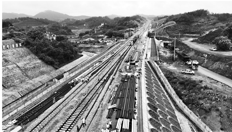
6月15日,龙龙高铁福建段全线铺轨贯通(傅艺鹏/摄)
