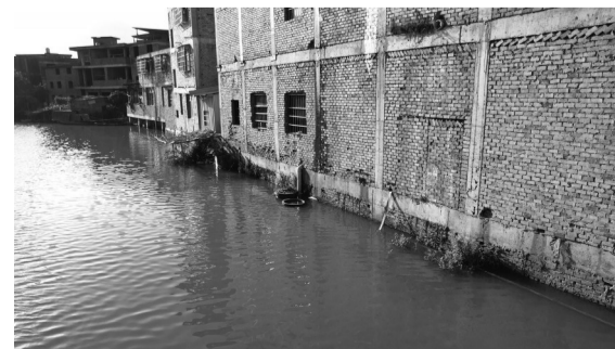
位于南通镇的私宰点,污水直排河道
