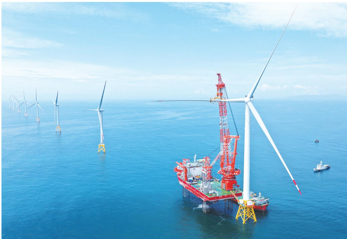
该机组轮毂中心高度152米,叶片长123米,单台机组每年可输出超过6600万千瓦时的清洁电能
