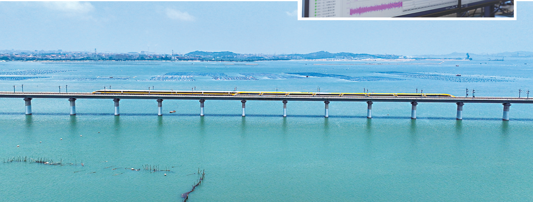
6月28日,在湄洲湾跨海大桥,试验列车交会运行
