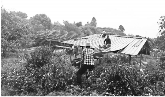
山头一处铁皮棚被拆除
