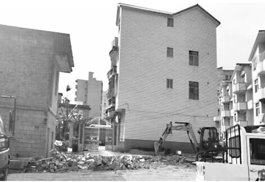
江田镇拆除一处违建砖混房屋
