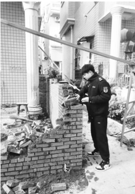
吴航街道拆除群众举报的一处扩建庭院
