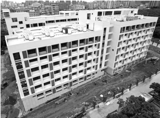
福师大泉州附中项目施工现场
