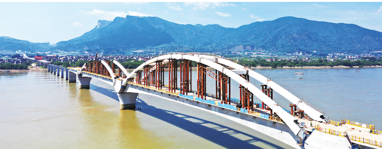
建设中的滨海快线帝封江站至祥谦站区间乌龙江大桥
