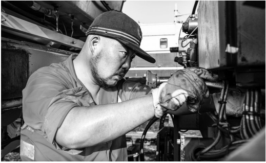
油管接头进行检修紧固 杨鹏正在对捣固装置
