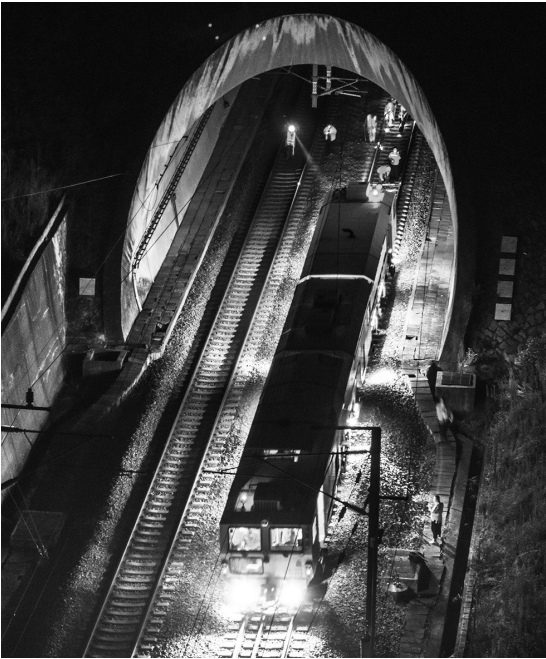
10日凌晨,杭深高铁莆田区段的捣固作业施工正在进行中
