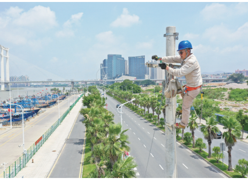
泉州市东海中央活力区后埔 拆迁地块建设配网迁改工程
