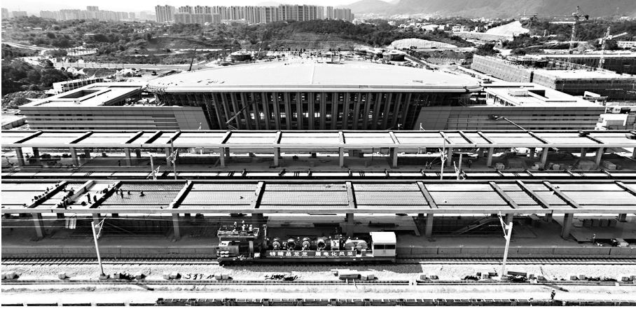
龙龙高铁福建段上杭北站建设现场(傅艺鹏/摄)
