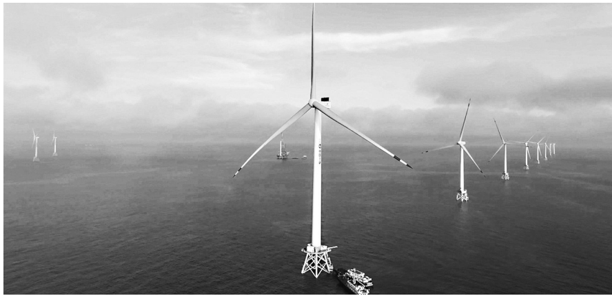
成功并网发电的16兆瓦超大容量海上风电机组
