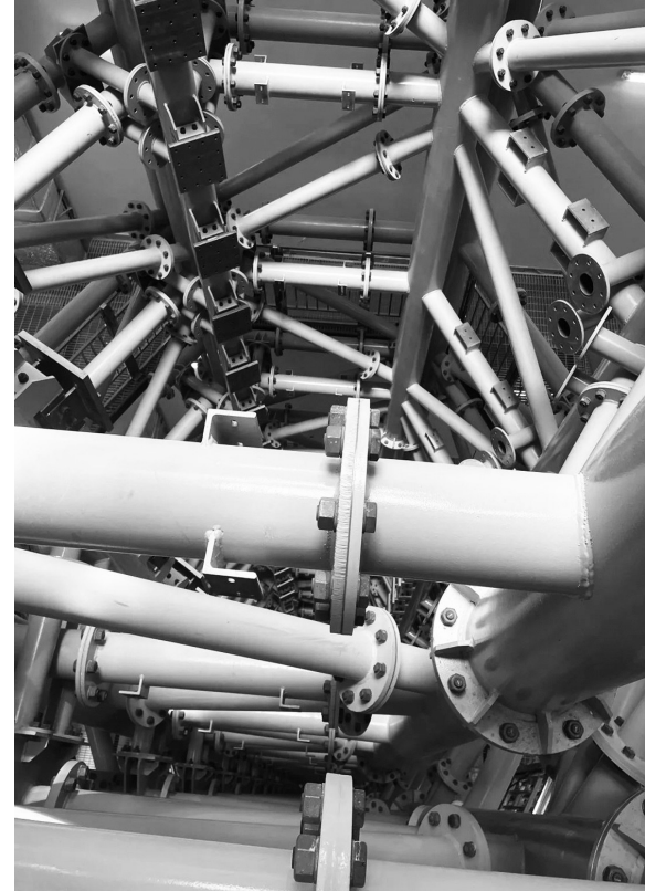
“4秒电磁弹射微重力实验项目”内部钢结构
