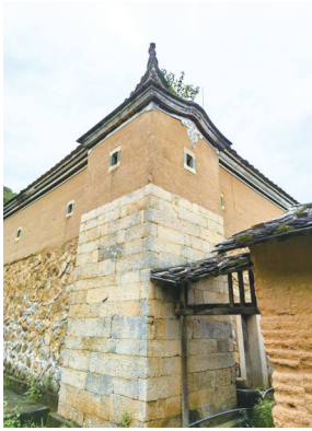
土楼侧翼的枪楼
