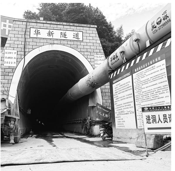
华新隧道是鹰厦铁路全线最长隧道,全长6921米(林涛/摄)
