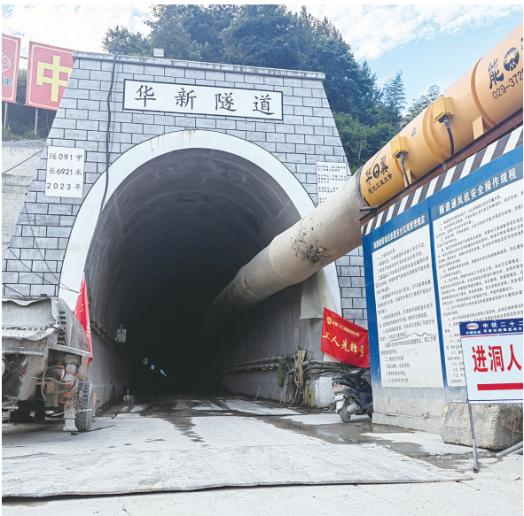
涌水和突泥是施工中最大的挑战(林涛/摄)
