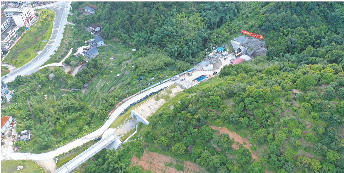
历时三年零六个月施工的鹰厦铁路华新隧道顺利贯通(林涛/摄)
