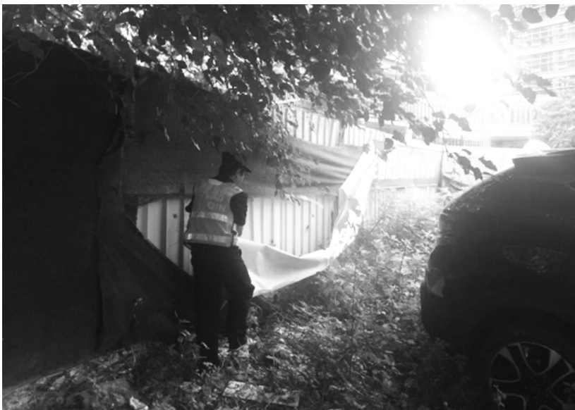
违搭广告牌拆除现场
