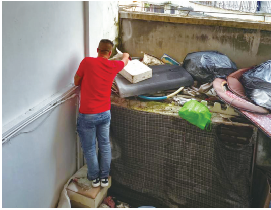
师傅在对漏水口进行封堵修复
