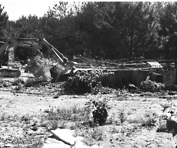
拆除违建养猪场
