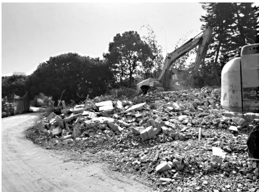
违建拆除现场
