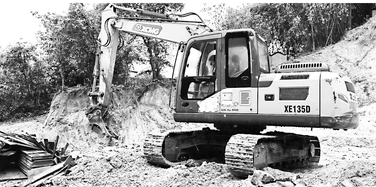
荆溪镇拆除关中村违建地基
