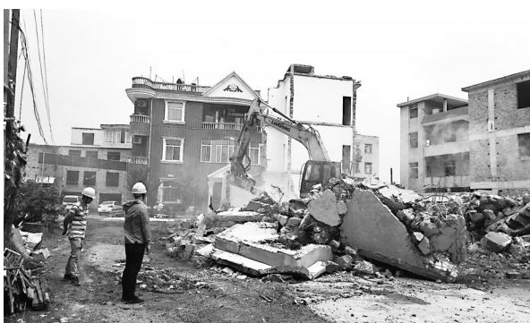
南通镇泽洋村违建楼房被拆除
