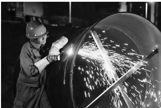
工人在焊接钢制管道
