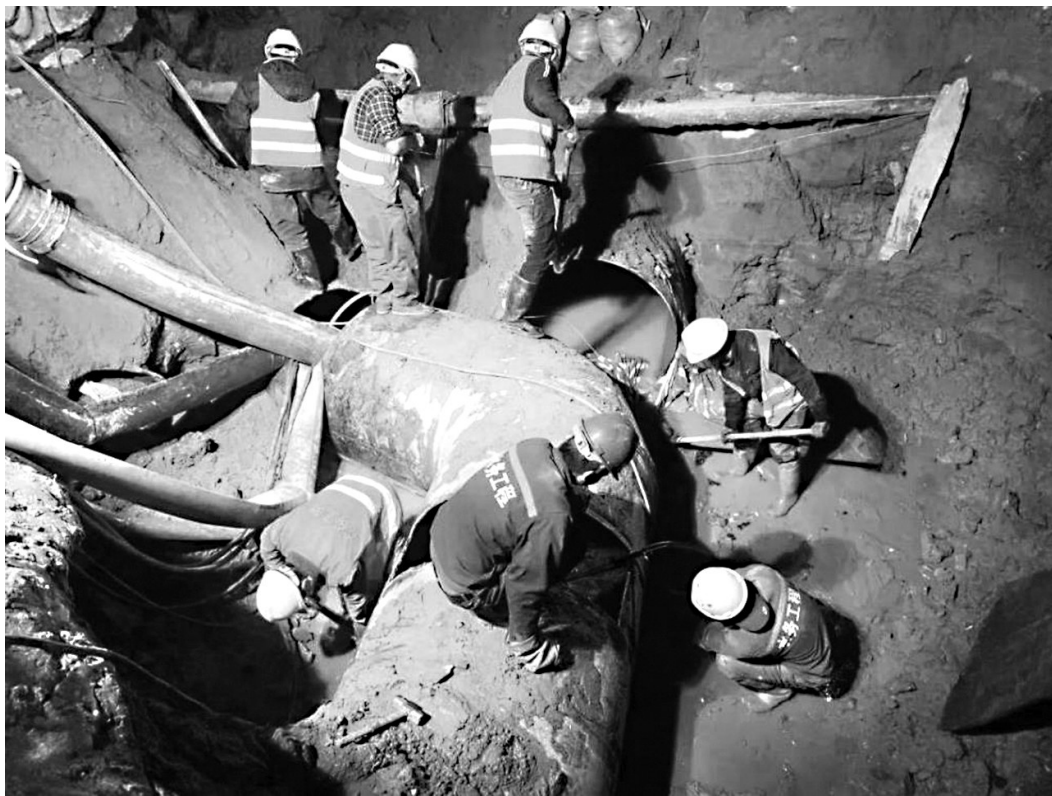
工人工人开挖管底土层以提供接驳作业面
