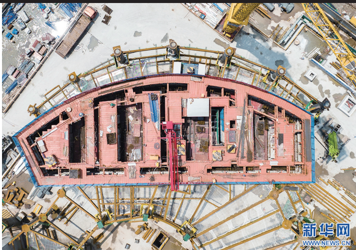
俯拍造楼机顶部,像移动的工厂
