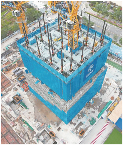
在建的厦门白鹭西塔项目
