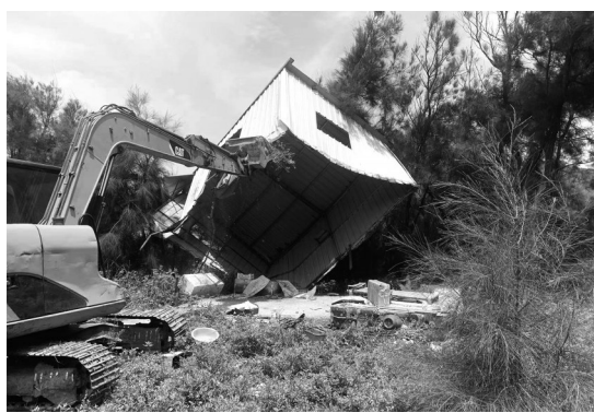
临时搭建的违建被拆除
